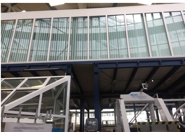
Hochebene (Seminarraum 030A, 030B), Hochebene Oberflächenmesslabor unter der Hochebene
